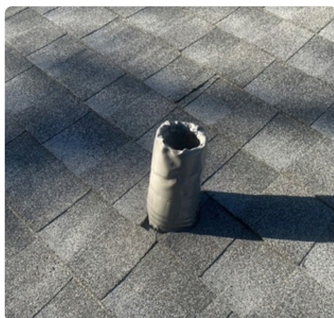
Flashing de tubería
