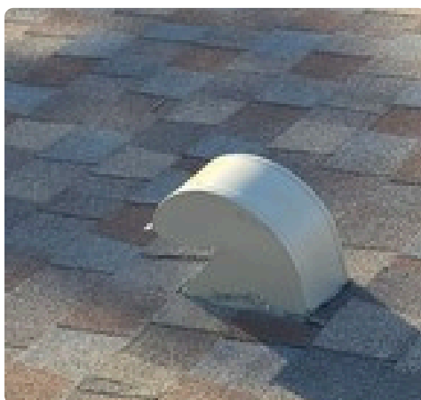
Flashings de ventilas
